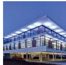
Schnepf Energietechnik Nagold (Germany)
