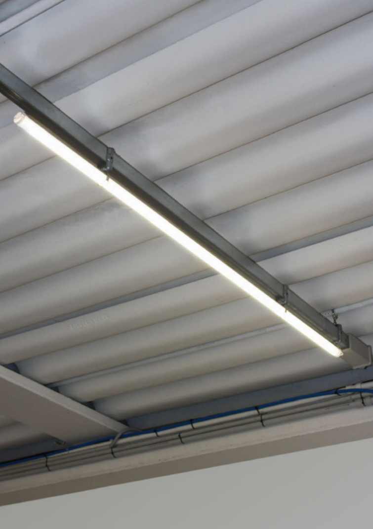
ESEMPIO DI INSTALLAZIONE SU BLINDOSBARRA EXAMPLE OF INSTALLATION ON BUSBAR
