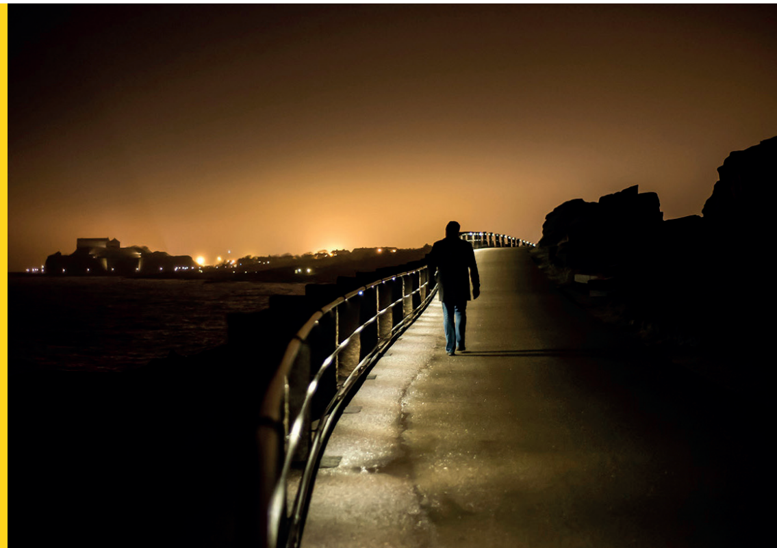
293 st HLS-puckar har monterats längs strandpromenaden i Varberg.
